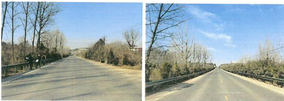
图 3.1-1 老路路面现状
