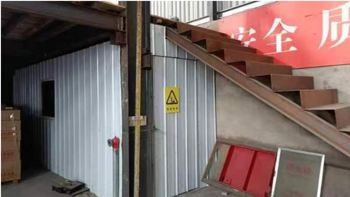
危险废物暂存间
