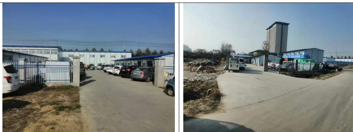
图 2.2-2 永临结合施工道路
