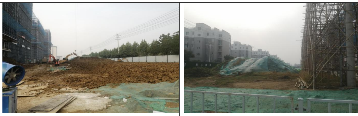
图 2.2-3 临时堆土情况
