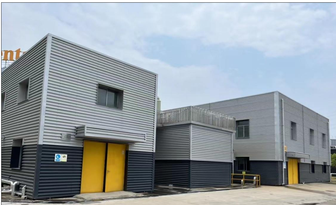
污水处理站现状照片
