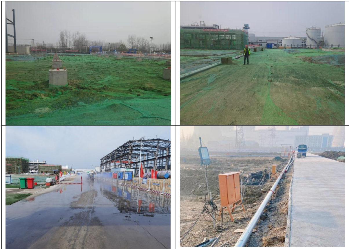
图 3.3-1 项目水保措施及工程现状
