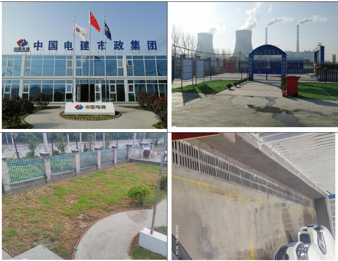
图 1.7-1 施工场地及施工办公区
