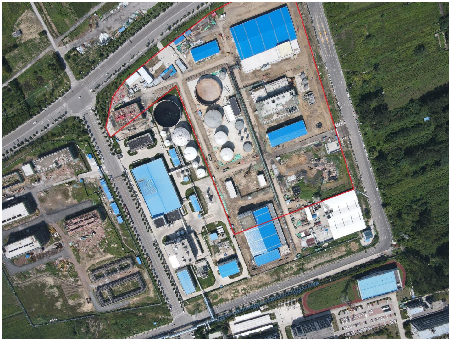
图 1.1-2 项目施工现状航拍图
