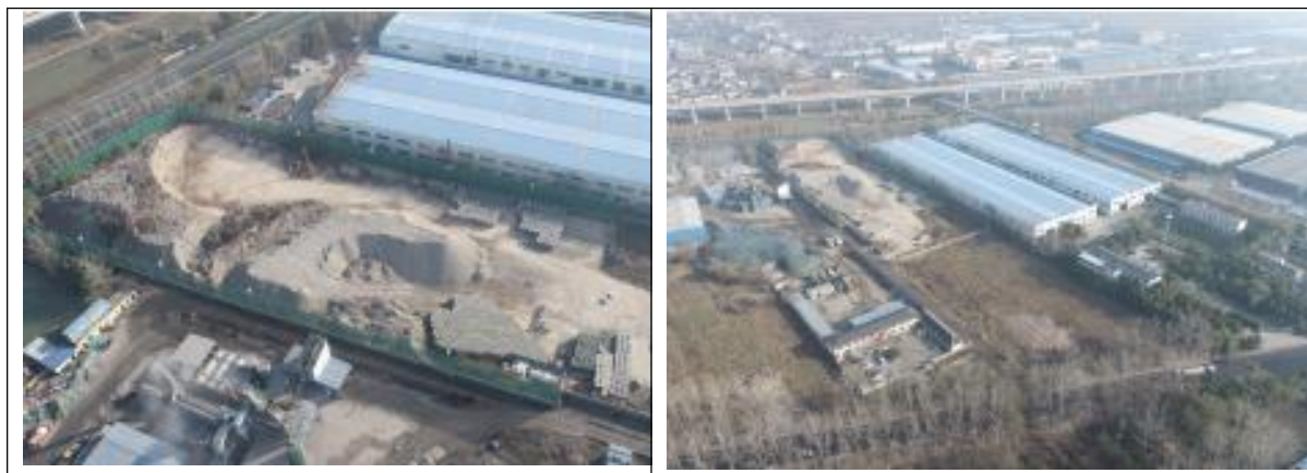
图 2-3 项目工程现状图
