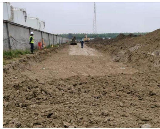
厂区西侧-南北向道路
