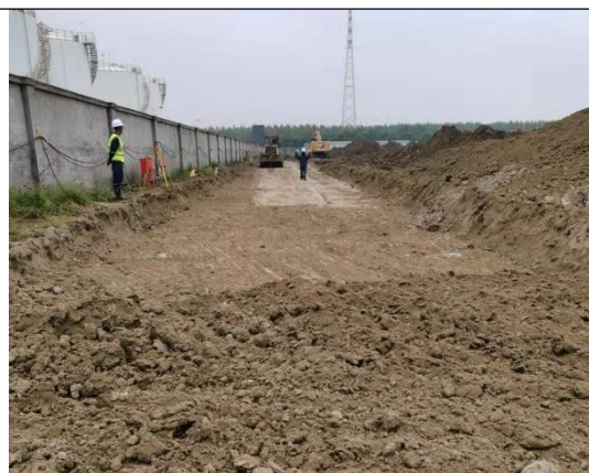
厂区西侧-南北向道路
