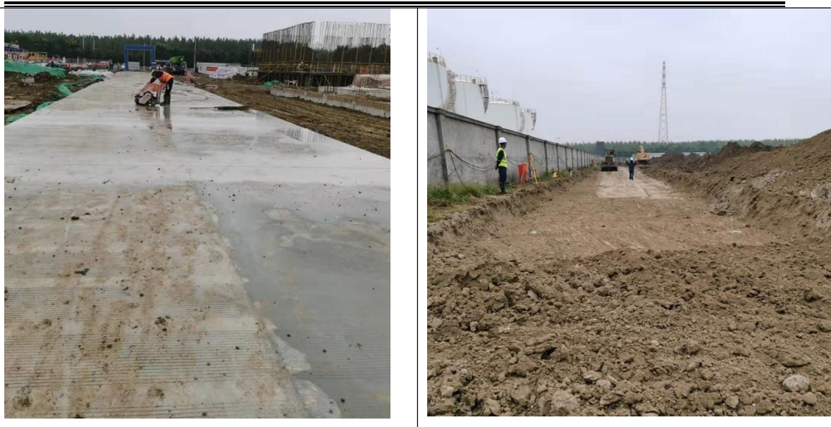
图 2.2-4 永临结合施工道路
