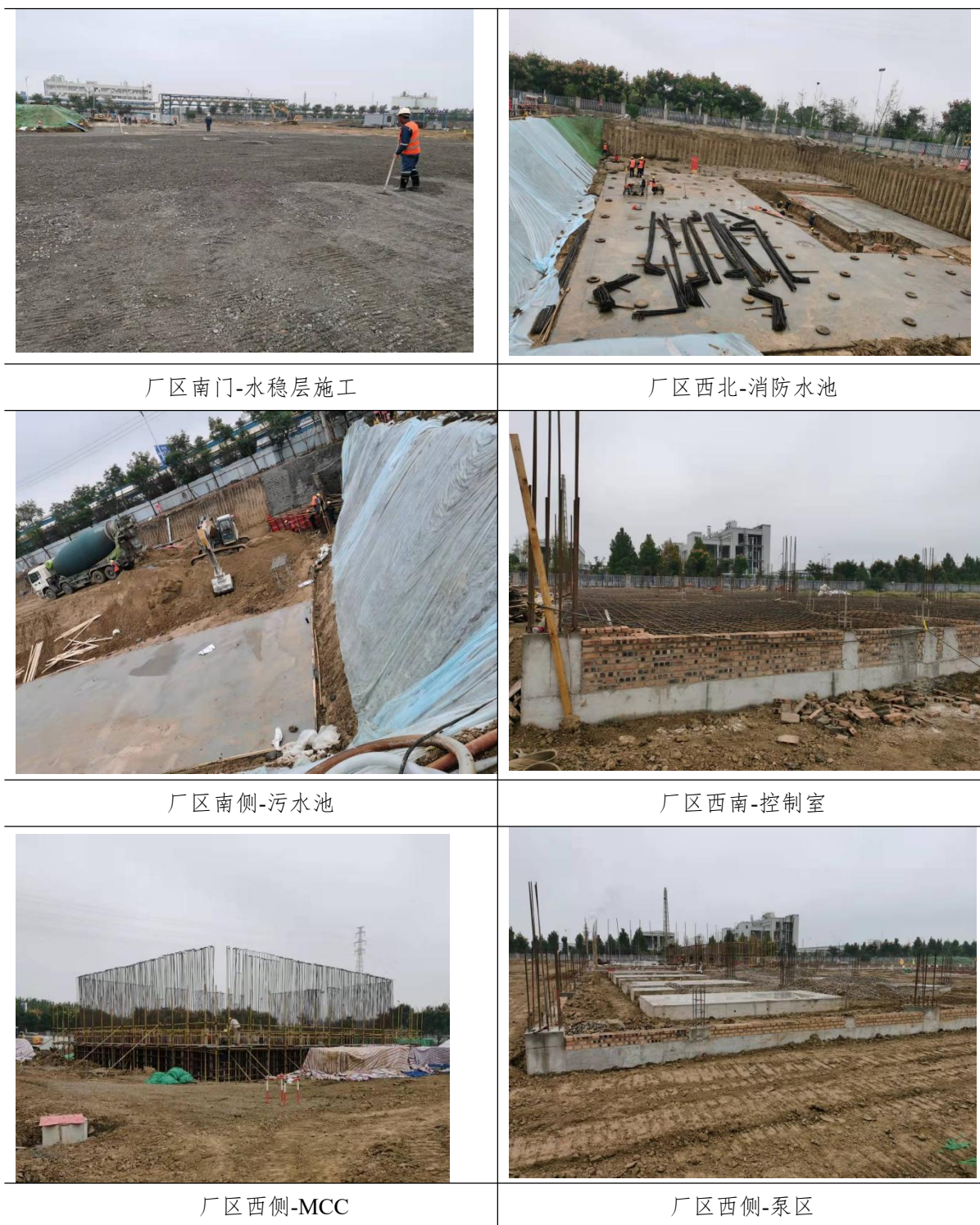
图 1.1-2 项目施工现状图
