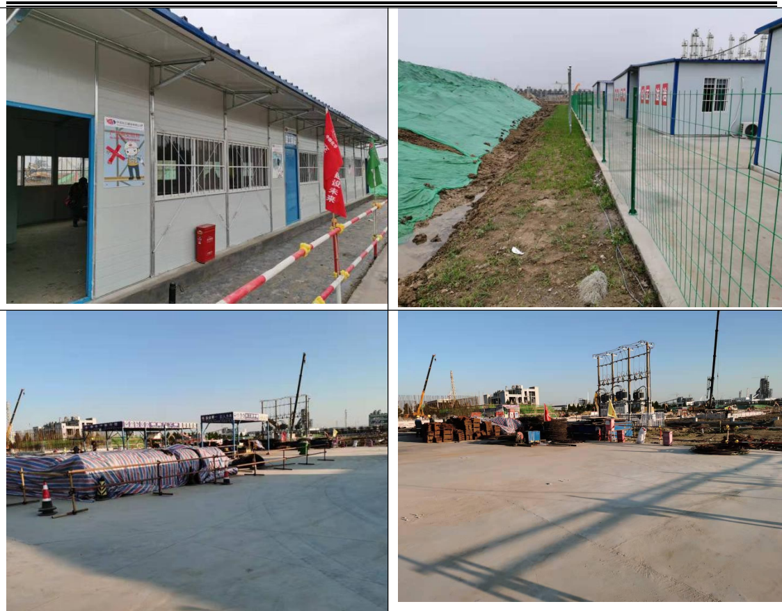
图 2.2-2 施工场地及施工办公区
