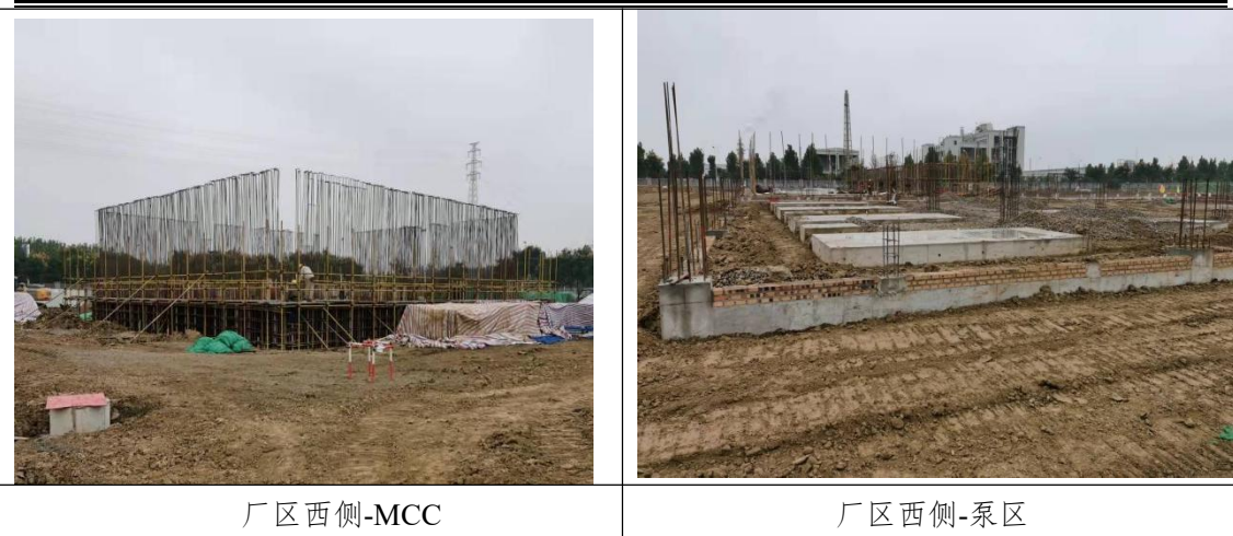
图 2.1-3 工程建设现状
