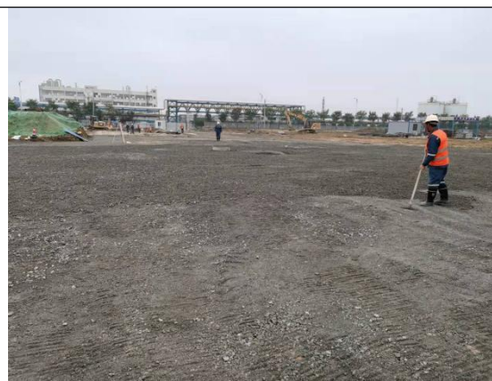
厂区南门-水稳层施工
